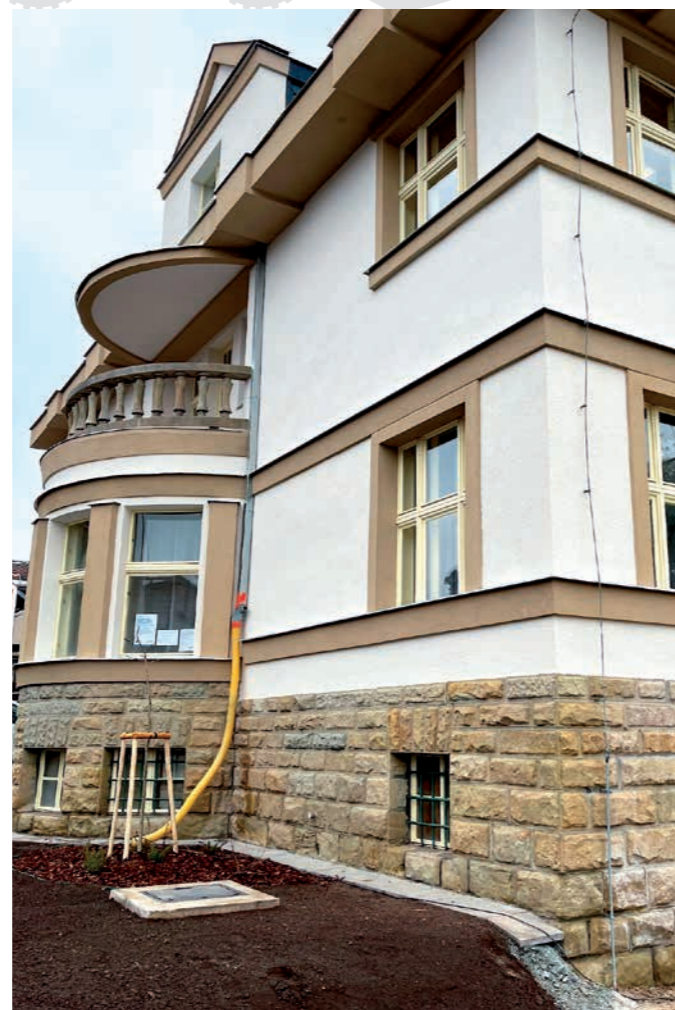
OBNOVA FASÁDY - KRAJKÁRSKÁ ŠKOLA MĚSTA VAMBERK
